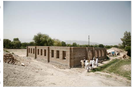
ساختمان جدید مکتب در ولایت ننگرهار تحت احداث قرار دارد.
