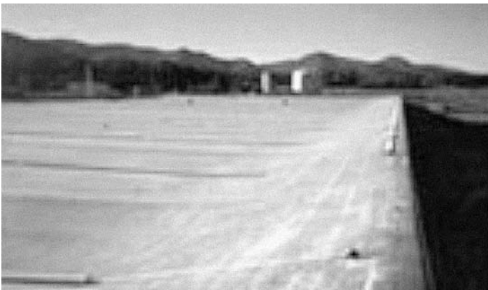
Figura 6 - GEOMEMBRANA CUBRE UNA LAGUNA ANAEROBIA
