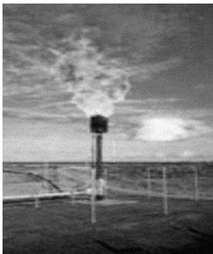
Figura 7 - SISTEMA DE CAPTACIÓN Y QUEMA DE GAS
