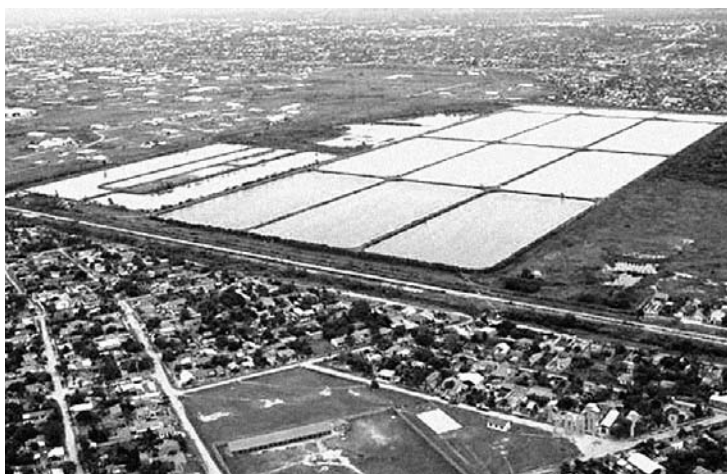
Figura 2 - FOTO AÉREA DE LA PLANTA ESTE DE TRATAMIENTO DE AGUAS SERVIDAS (Planta E) de Santa Cruz
