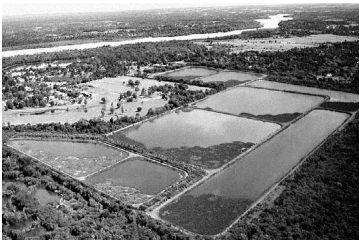
Figura 3 - FOTO AÉREA DE LA PLANTA NORTE 2 DE TRATAMIENTO DE AGUAS SERVIDAS (Planta N2) de Santa Cruz
