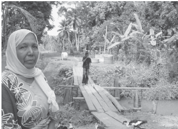
Jembatan yang menghubungkan Desa Alue Teungoh dengan Desa Alue Raya Kecamatan Panga Aceh Jaya. Hingga saat ini belum ada jembatan permanen yang melintasi dua desa yang terkenal sebagai kawasan "hitam" saat konflik dahulu.
