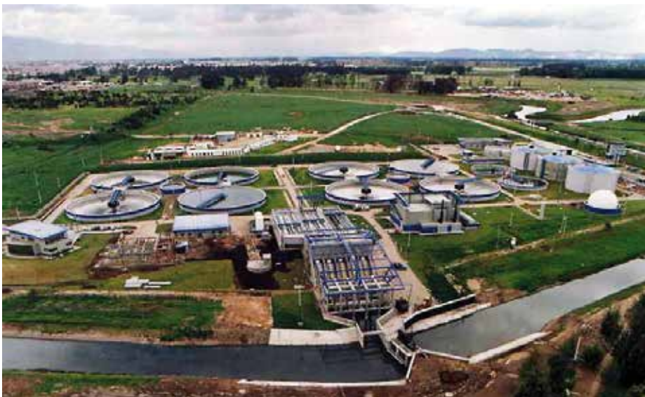
Planta de Tratamiento de Agua Residual Salitre. Fuente: Empresa de Agua y Alcantarillado de Bogotá (EAAB).
